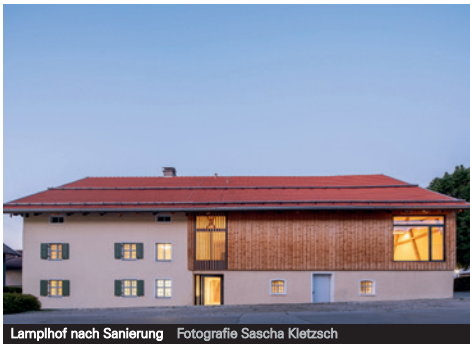
Lamplhof nach Sanierung Fotografie Sascha Kletzsch
