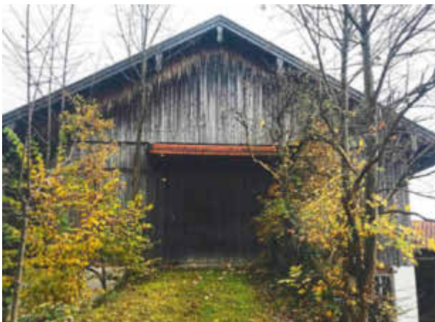
Ohne Tageslicht wirkte die Tenne vor dem Umbau im Bereich der Rampe wie eine dunkle Höhle
