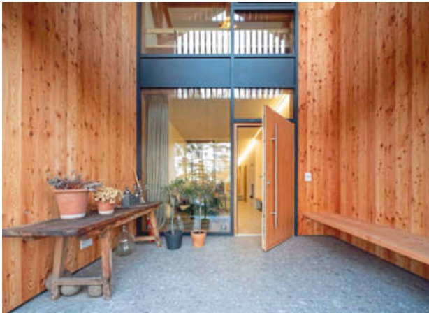
Über den Rampenzugang trifft man heute auf das gebäudehohe Glasfassadenelement mit integrierter Haustür
